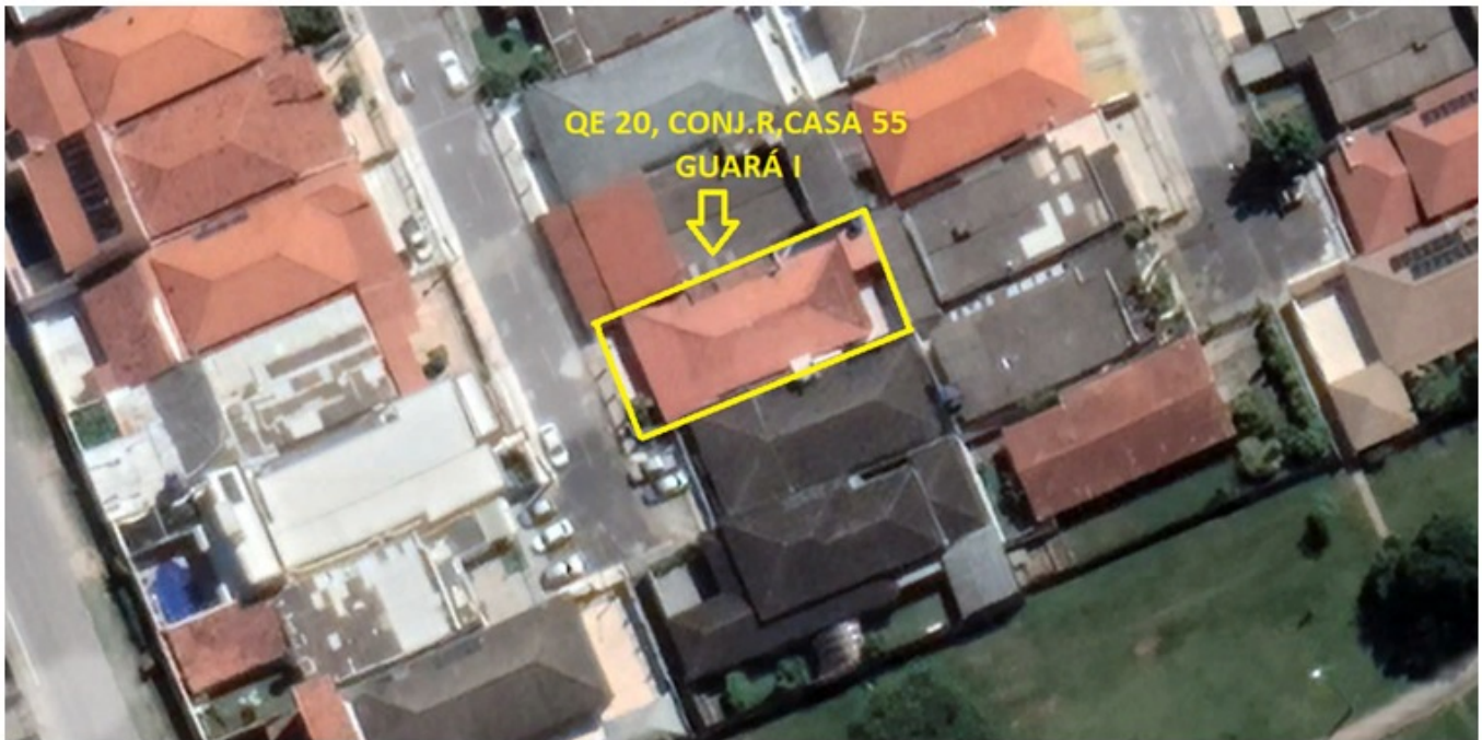
Fig.1: Vista aérea da edificação
