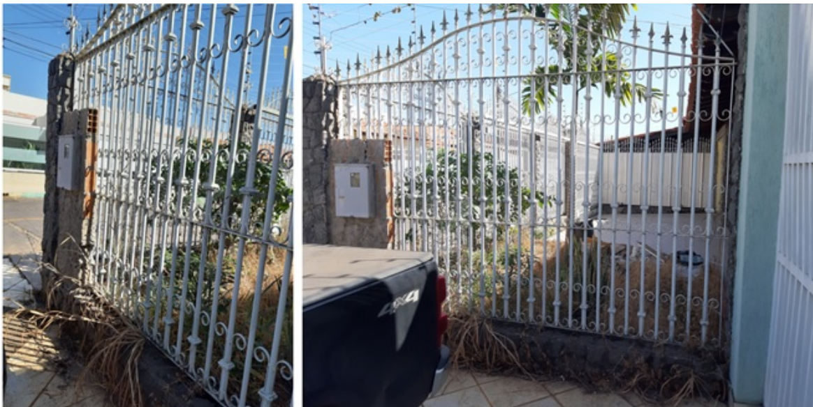
Fig. 7: Fachada lateral do imóvel
