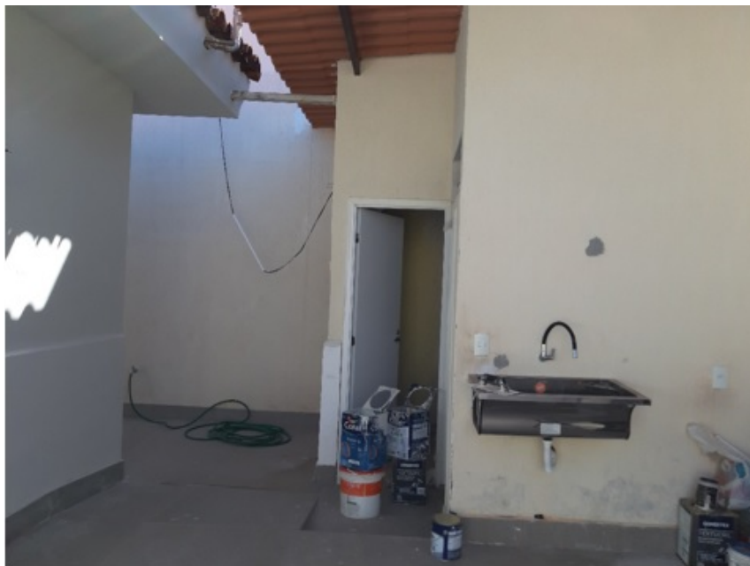
Fig. 18: Área de serviço/ pintura a finalizar
