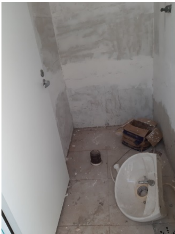
Fig. 19: Wc serviços/ cuba e bacia a instalar/ revestimento a instalar
